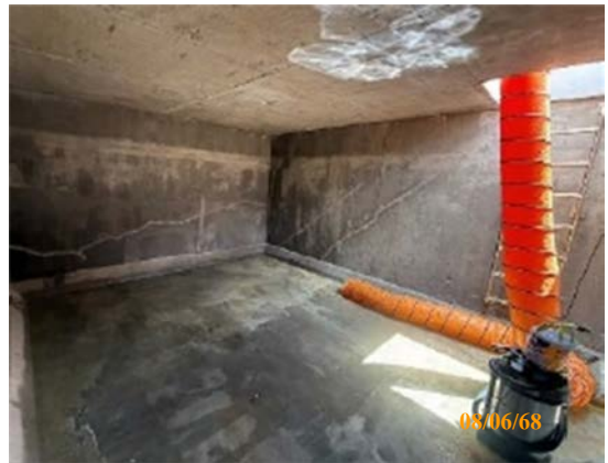
รูปที่ 2-67 การล้างถึงน้ำสำรอง
