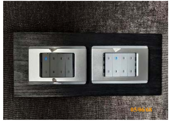
รูปที่ 2-45 ระบบปรับระดับแสงสว่าง (Dimmer)
